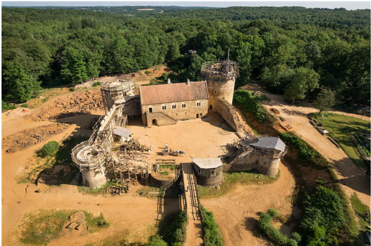
Burgbaustelle Guédelon (Département Yonne)
